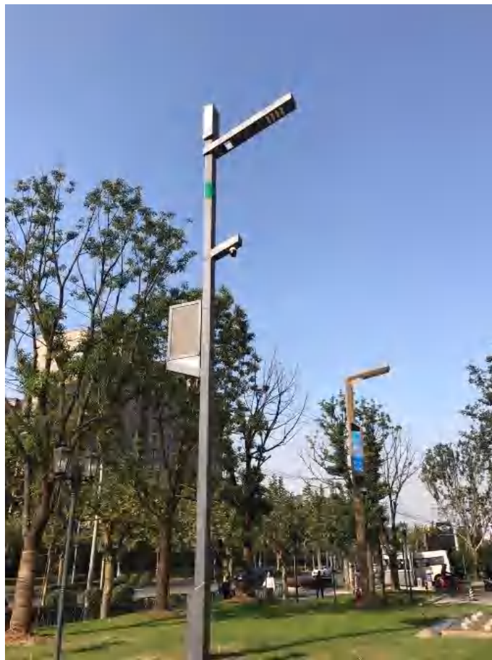
图 3-1 搭载 5G 微基站的智慧杆
